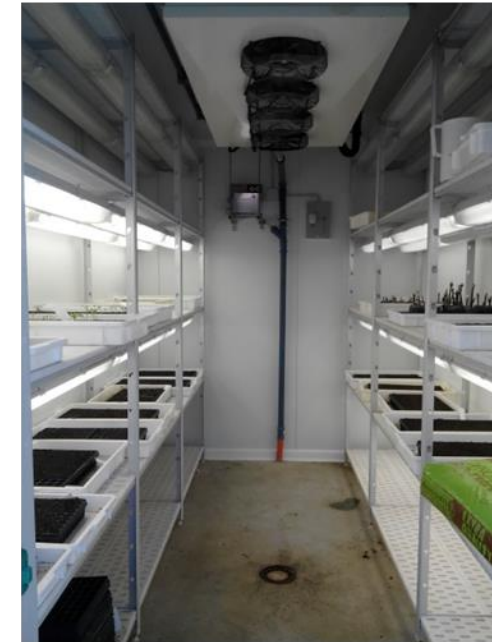
Vaschette in CELLA CLIMATICA (umidità elevata 60-70% temperatura circa 28 °C)
